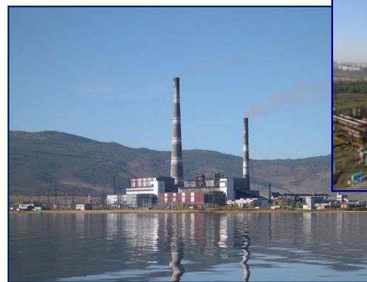
Гусиозерская ГРЭС (К-200)
