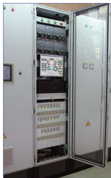
Стойка с контрольно-измерительными модулями «АЛМАЗ-7803» и программным комплексом «АЛМАЗ-МОНИТОР»
